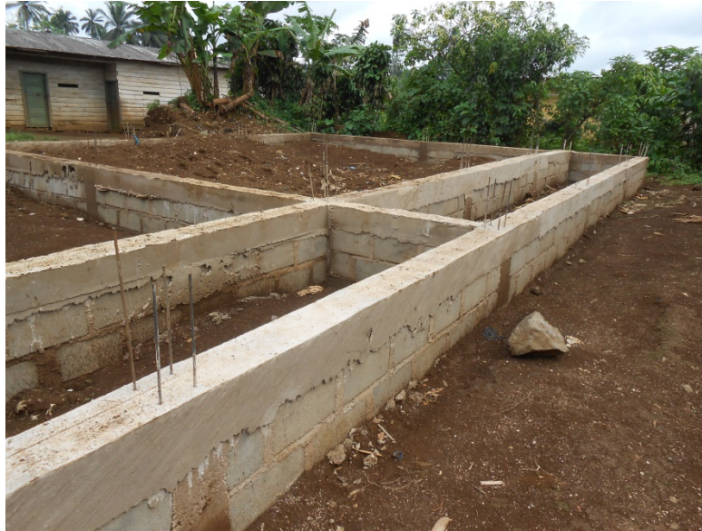
Vue de la fondation = bloc de 2 salles de classe
